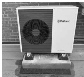
Monoblock-Wärmepumpe außen
